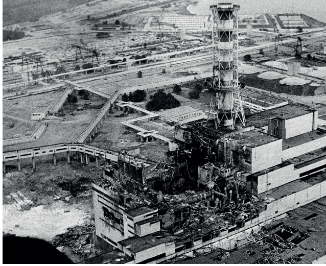
Şekil 4.4 : Kaza Sonucu Hasar Gören Çernobil Nükleer Santrali 18
